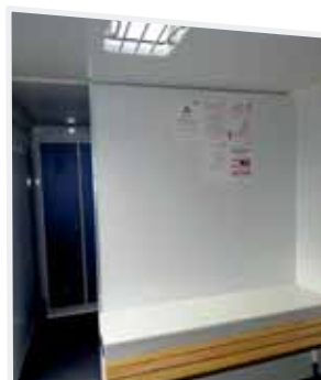
Cloison de séparation
